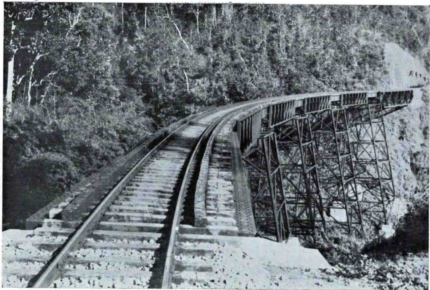
สะพานทางรถไฟสายเหนือ
