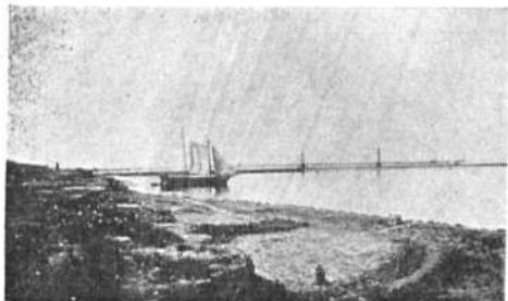
Mateosos interiores del dique de arena.
