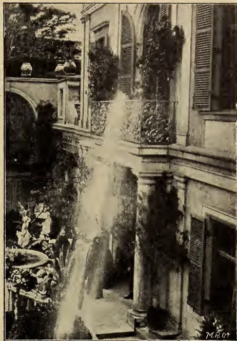
Abb. 62. Villa Lenbach in München. Fassade des Quergebäudes.
