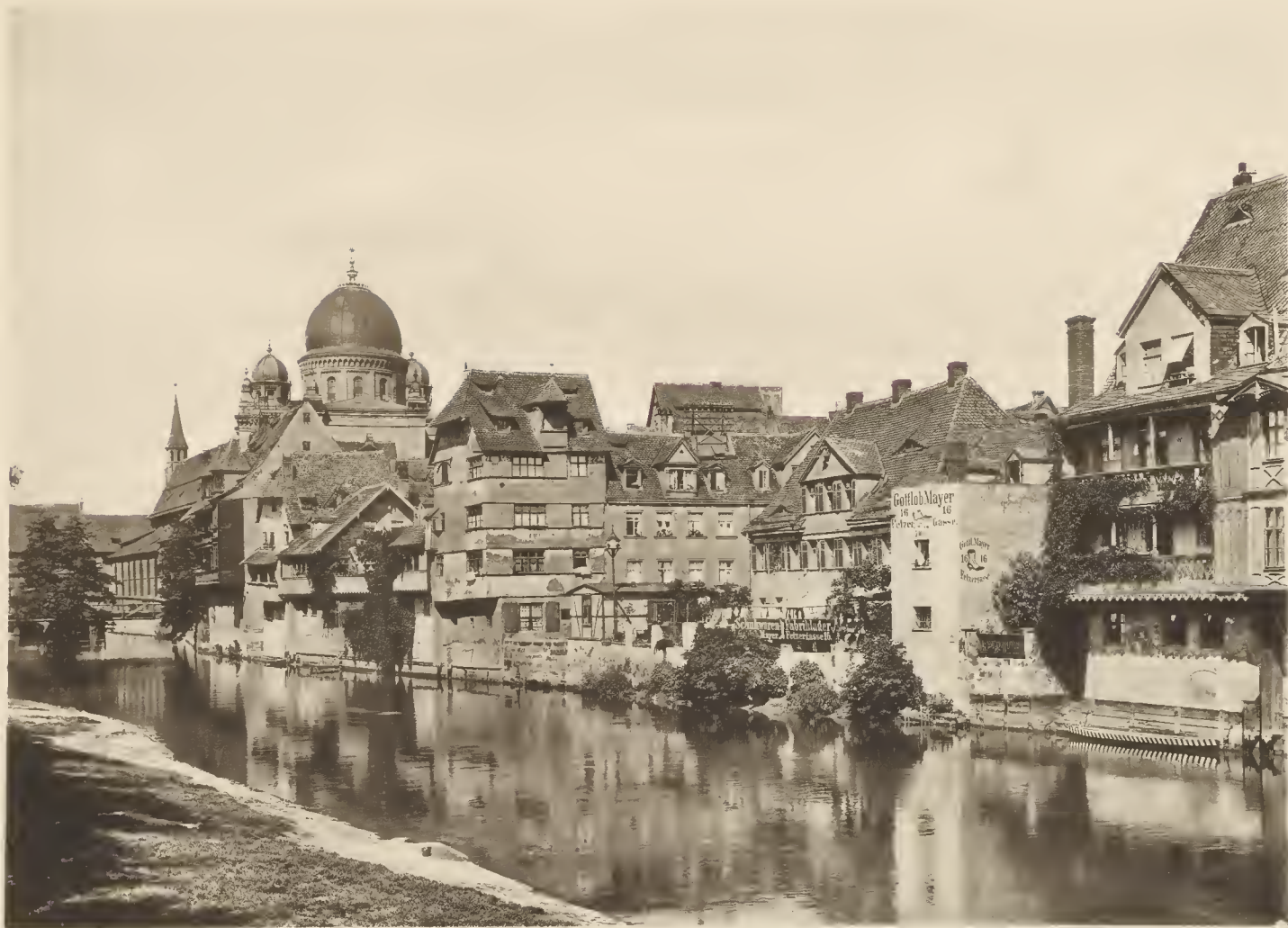
Abb. 35. Pegnitzpartie an der Insel Schütt.
