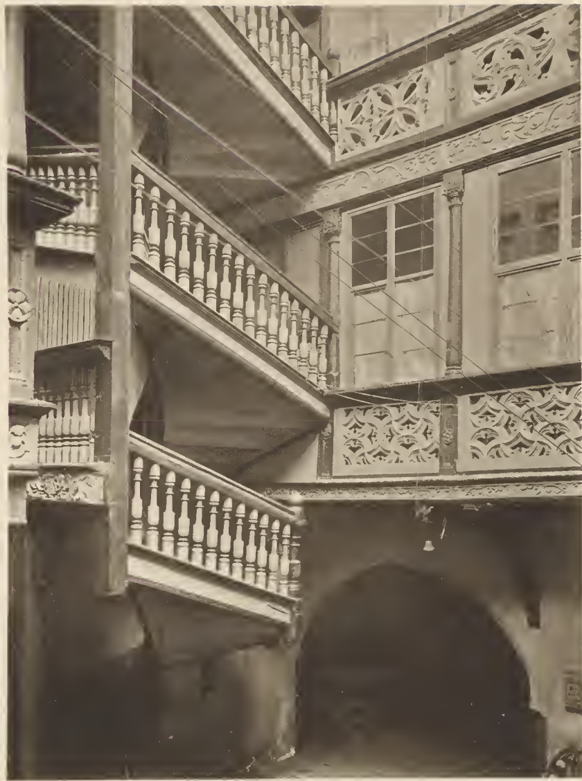
Abb. 74. Treppenanlage im Hof Tucherstrasse 15. 1543.
