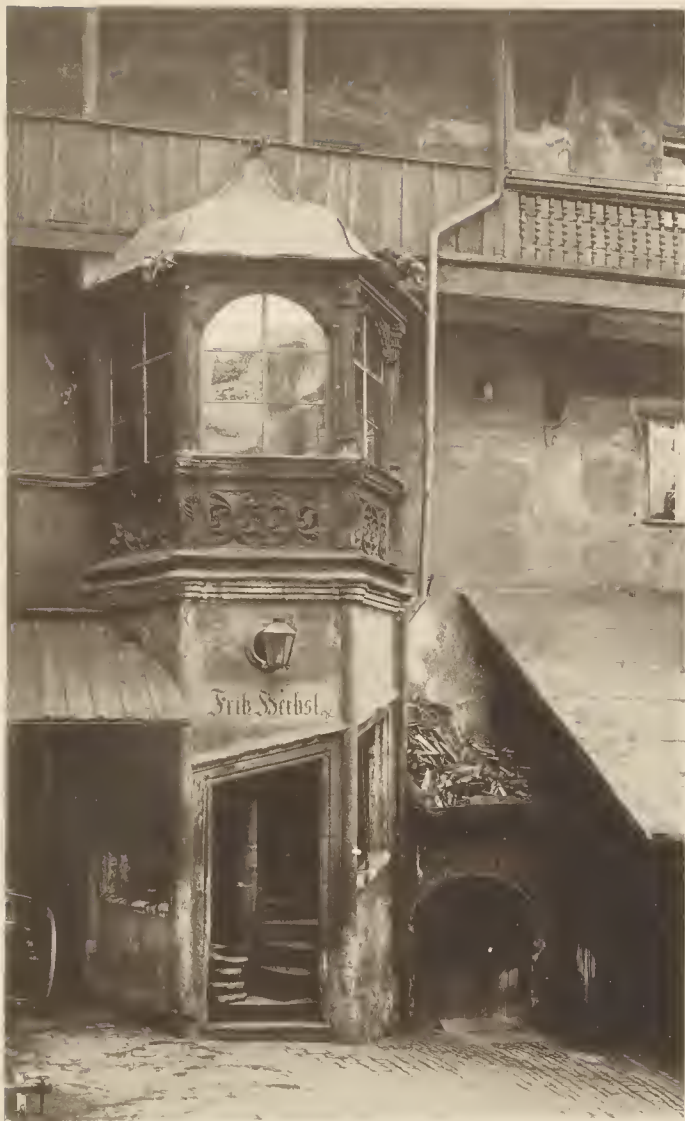
Abb. 90. Treppentürmchen im sogenannten Kutschershof, Brunnengasse 14 und 16. Um 1600.
