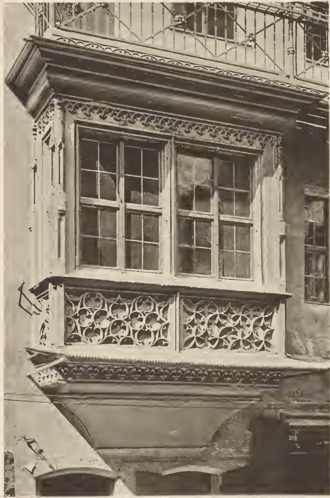
Abb. 51. Chörlein im Hof Egdienplatz 11/13. 1480—1490.
