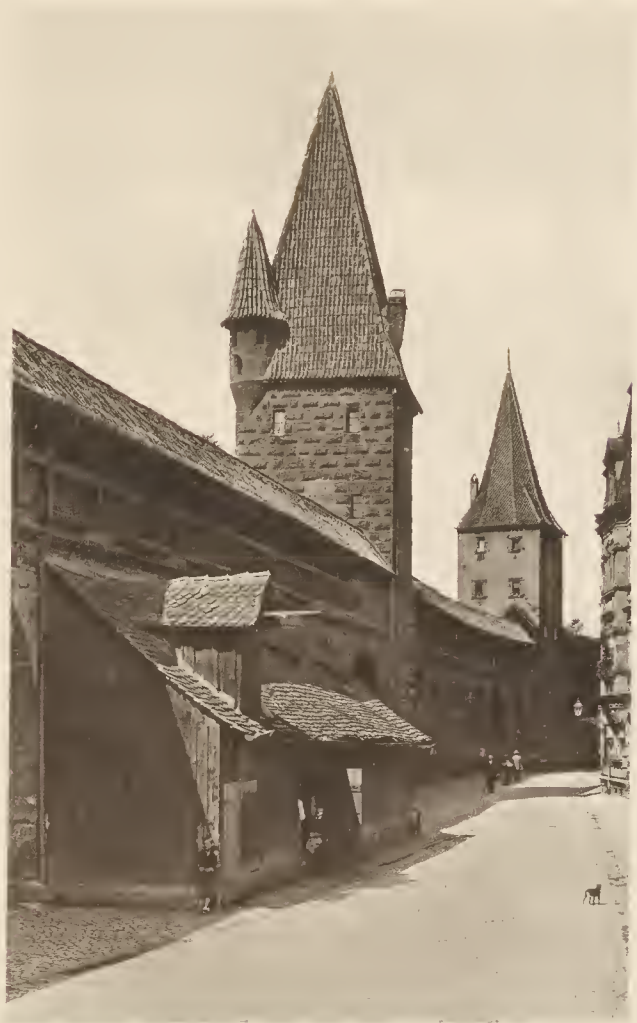
Abb. 18. Innere Mauer an der Engelhardsgasse.
