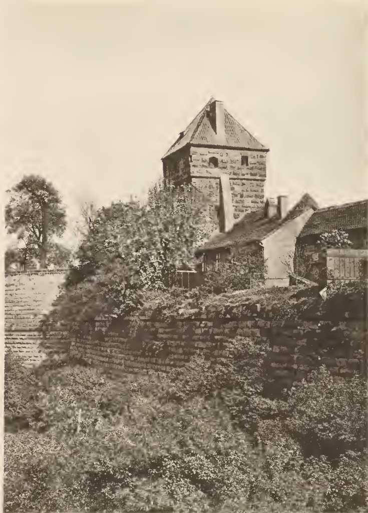
Abb. 19. Mauerpartie am Maxtorgraben.
