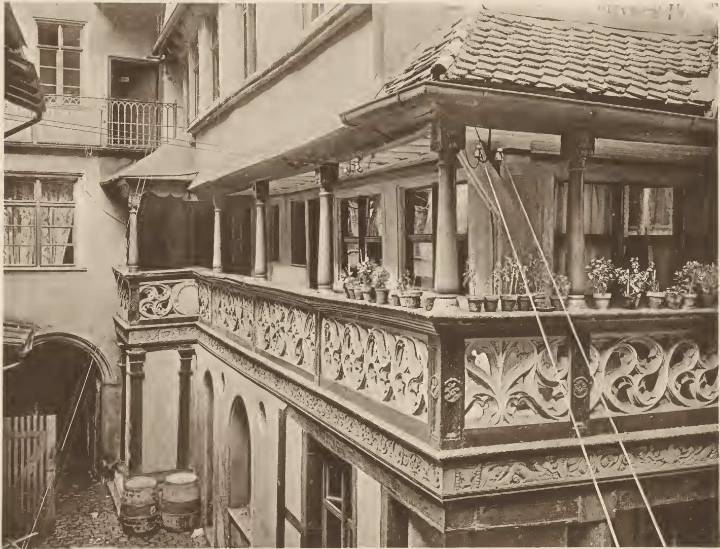
Abb. 75. Partie aus dem Hof Tucherstrasse 15. 1543.
