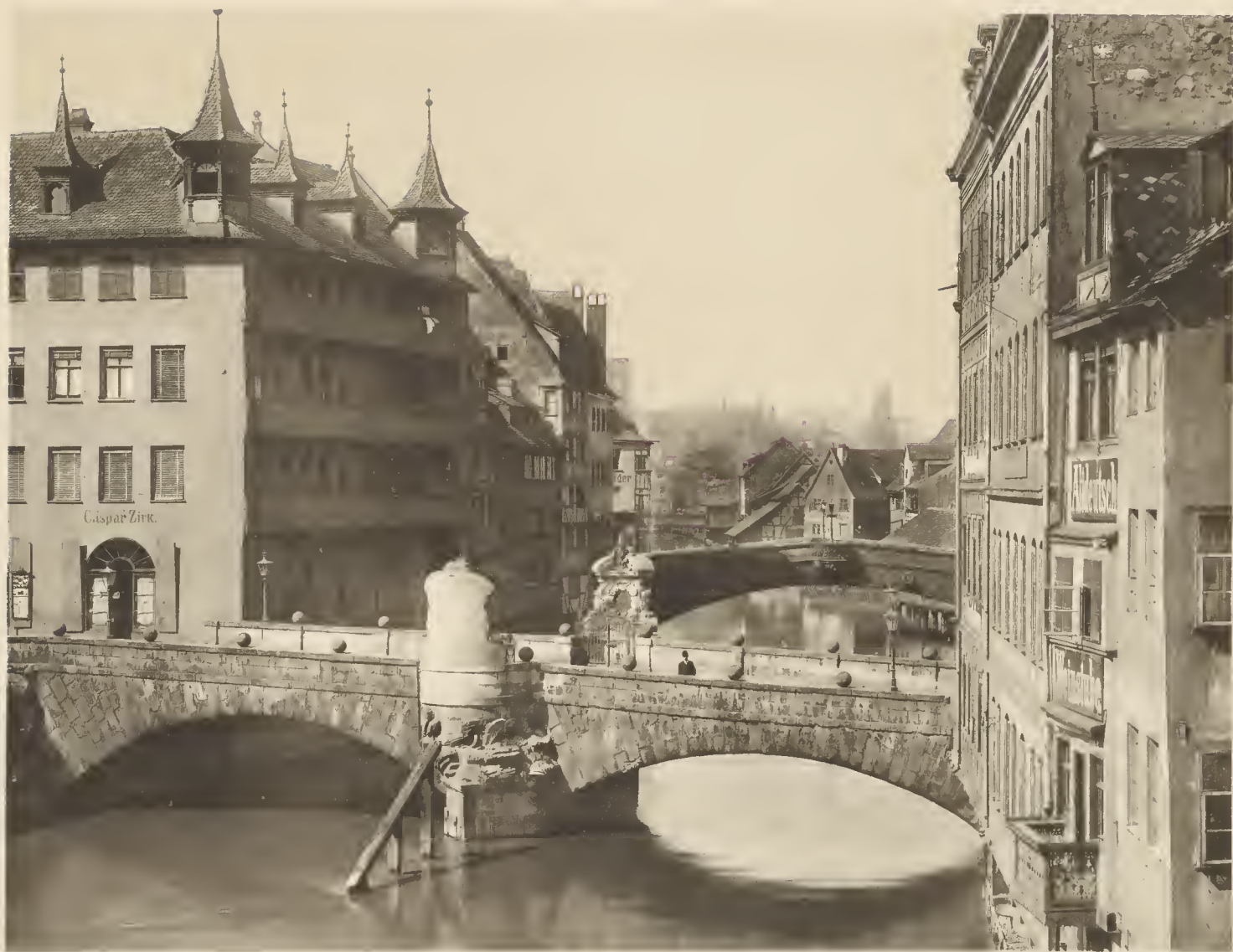
Abb. 36. Museumsbrücke und Fleischbrücke.
