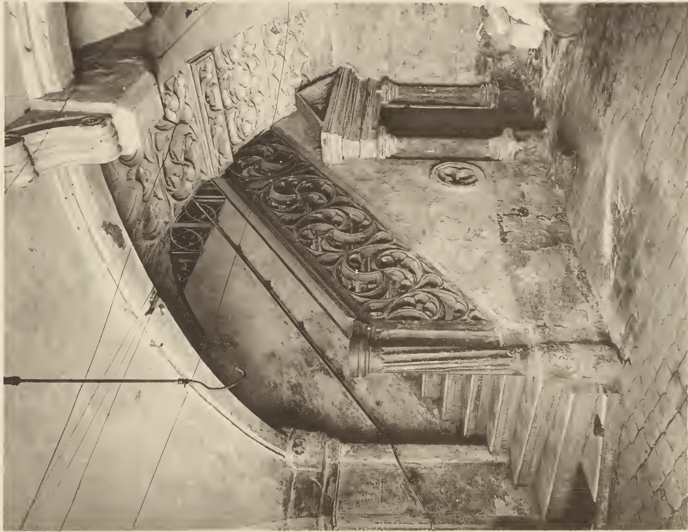
Abb. 89. Treppenaufstieg im Hause Winklerstrasse 5. Um 1600.
